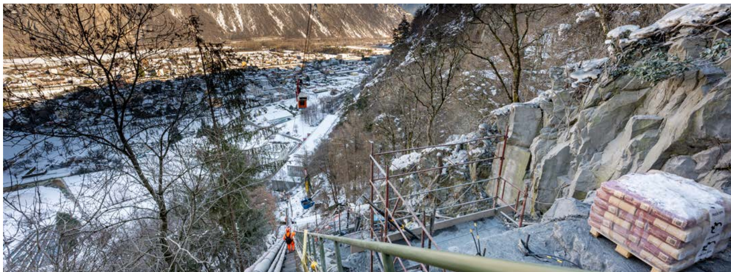
Construction de la ligne CFF en souterrain dans la descente vers Vernayaz, février 2023
