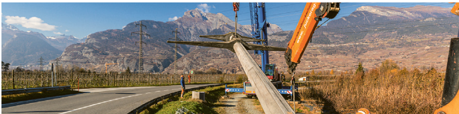
Démontage de la ligne de 65 kV Riddes – Vétroz, novembre 2021
