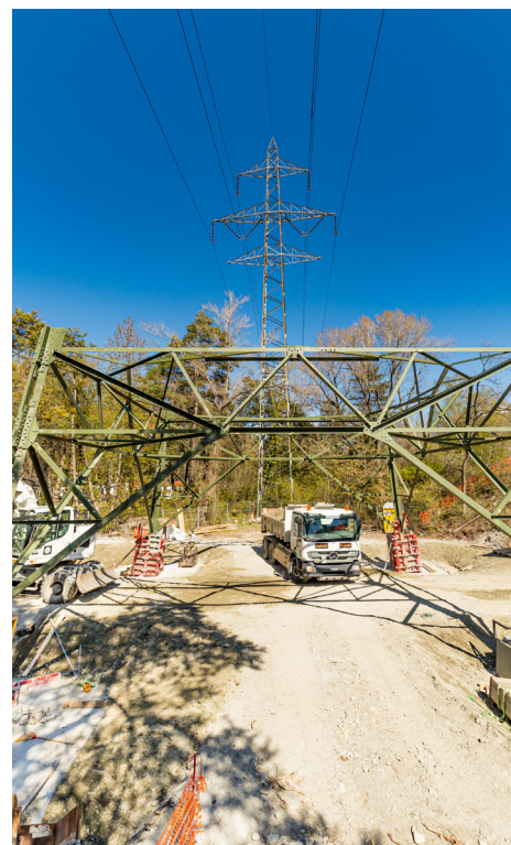
Les bases du pylône 115 à Aproz ont été posées sous la ligne actuelle.
