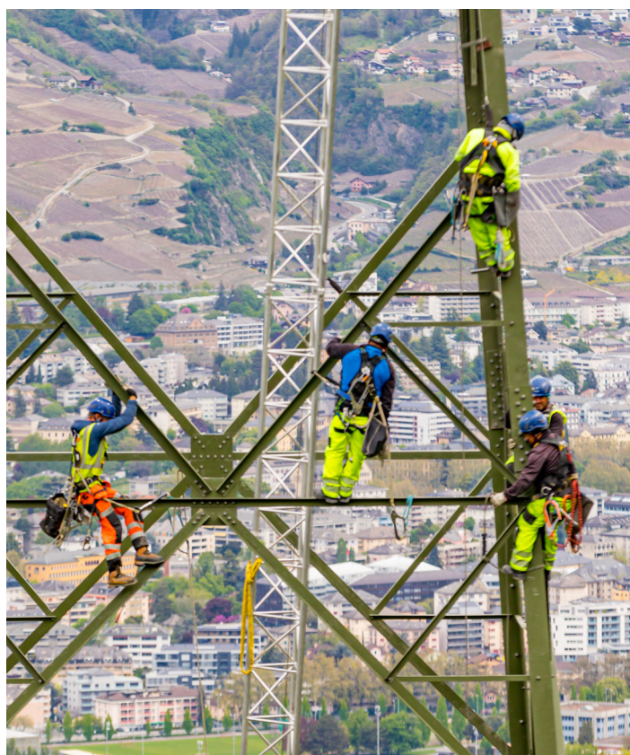
Montage du pylône 122 à Salins.
