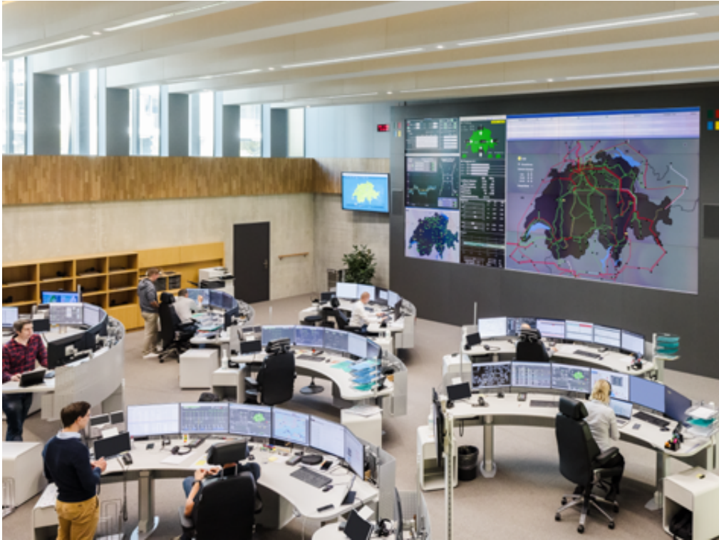
Les collaborateurs du centre de contrôle de Swissgrid gèrent le réseau 24h/24 et 7j/7.
