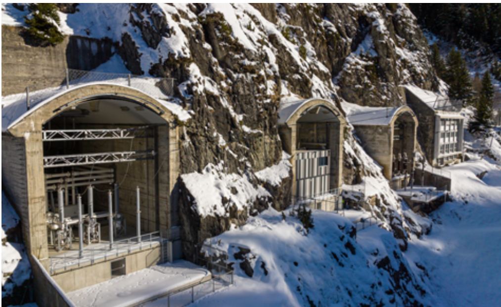
Sous-station Swissgrid « Fionnay GD » en Valais
