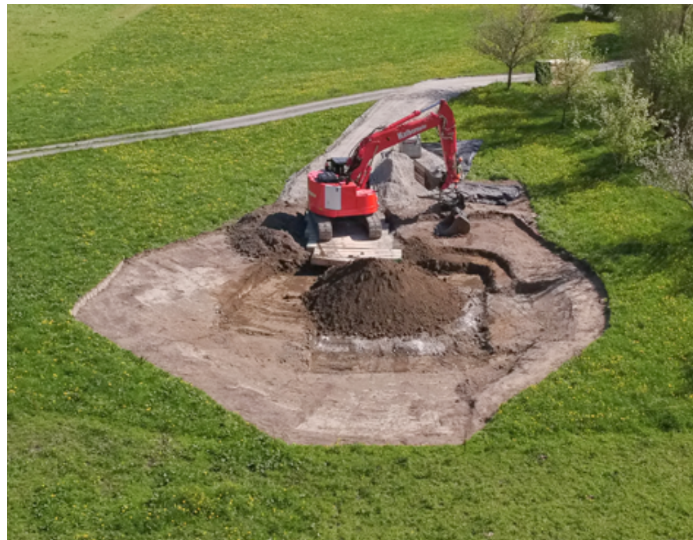
Exemple d'assainissement de sol © Oliver Iseli
