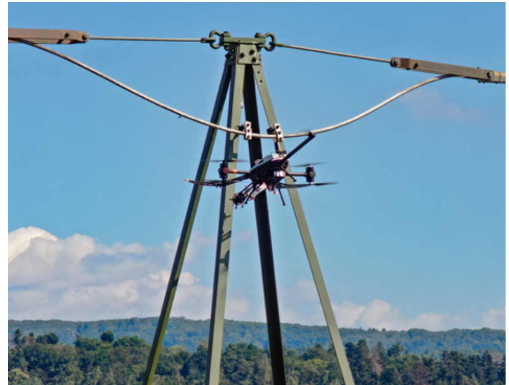
Les analyses de corrosion par drone sont standardisées, plus rapides et plus sûres.
