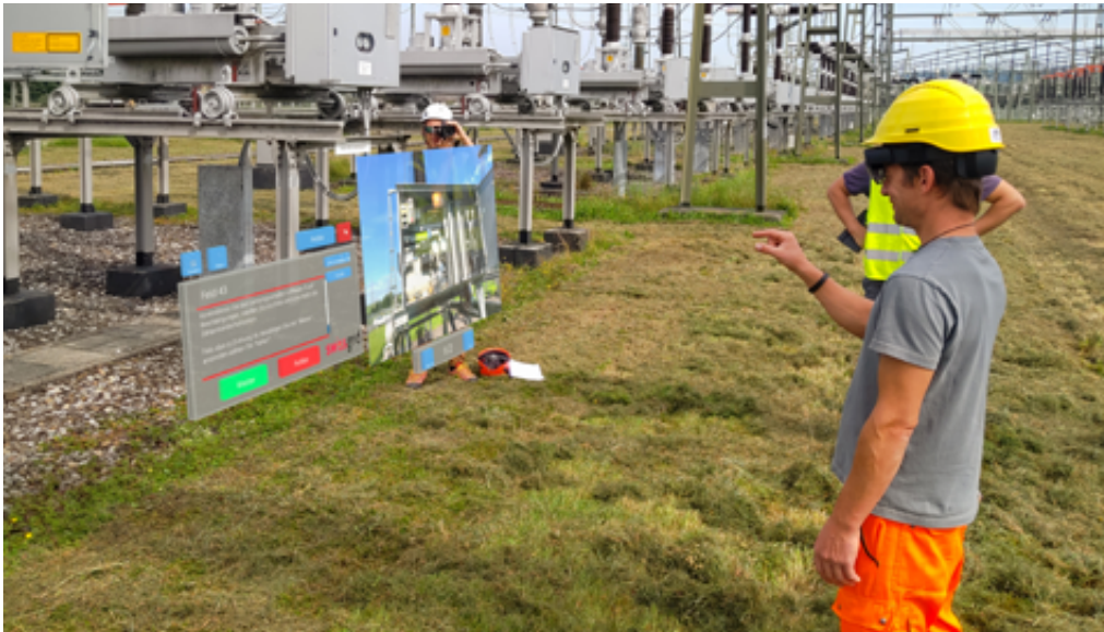
La réalité augmentée aide les collaborateurs de Swissgrid lors de l'inspection.
