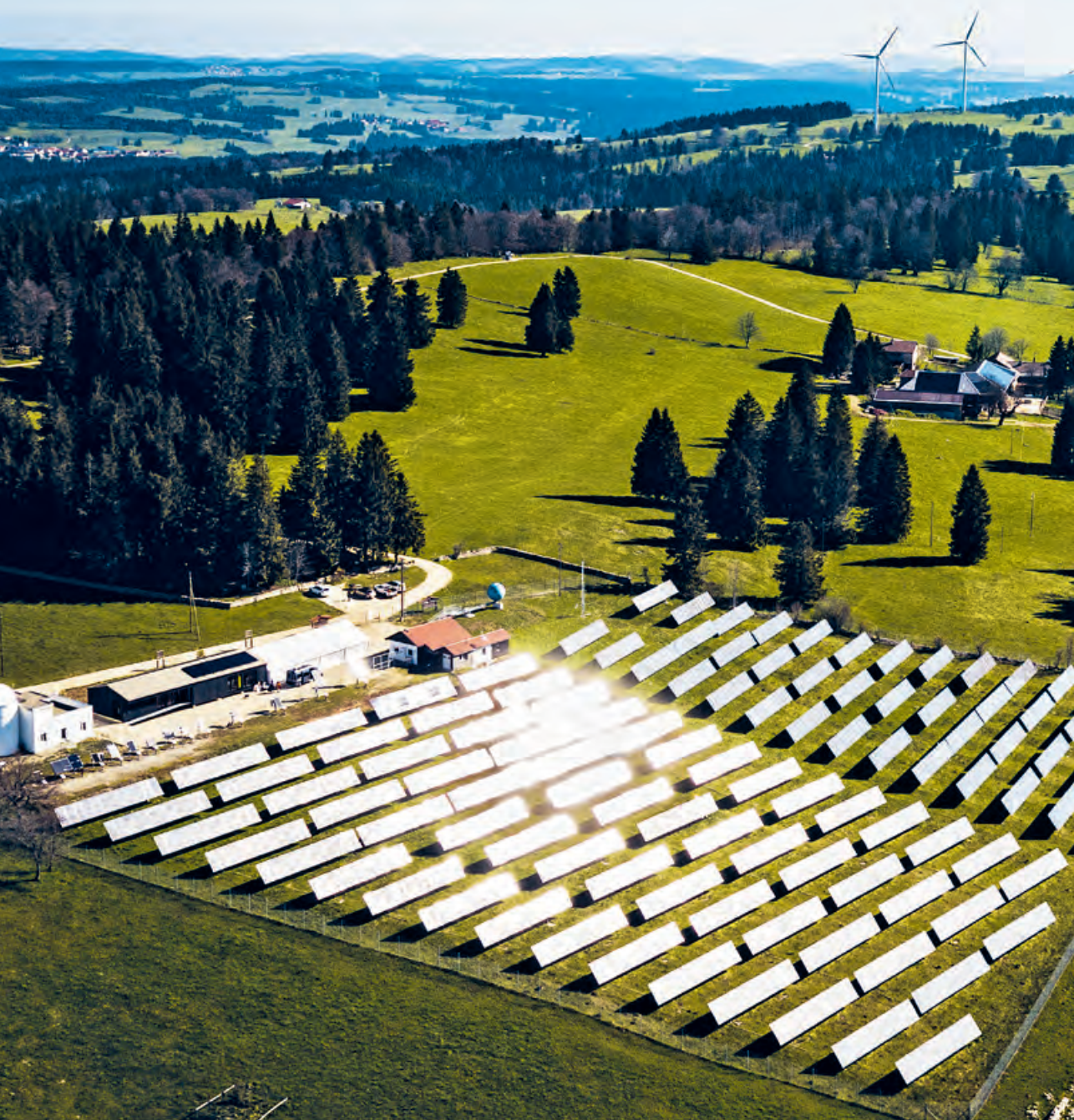
Les énergies renouvelables ont le vent en poupe. Depuis les années 1990, le Mont-Soleil produit de l'électricité à partir de l'énergie photovoltaïque et éolienne.
