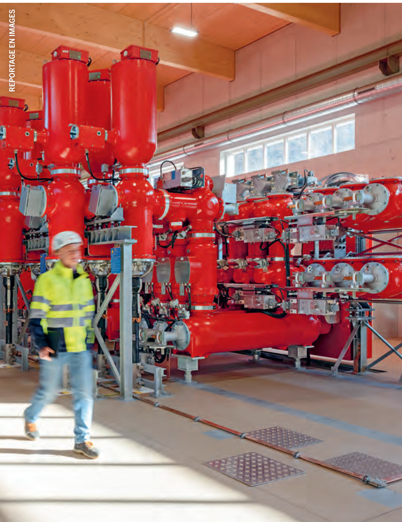
Infrastructure. La sécurité de l'exploitation du réseau de transport dépend du bon fonctionnement de l'infrastructure.
