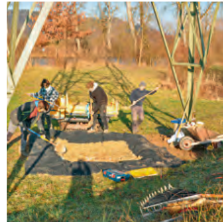
Construction d'une mare sous un pylône
